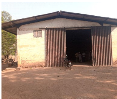
Photo 5 : Magasin de stockage datant de l'époque coloniale a Kambolé (Togo)
