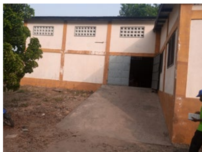
Photo 2 : Magasin de stockage en matériaux définitifs à Atapkamé (Togo)
